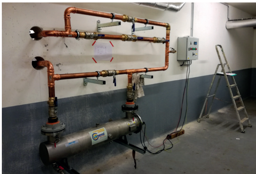
En parallèle des hôpitaux et des ERP, UV-Germi équipe de plus en plus de réseaux d'eau chaude sanitaire installés dans les bâtiments collectifs.
