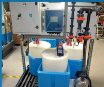
Skid de traitement des eaux d'une TAR
