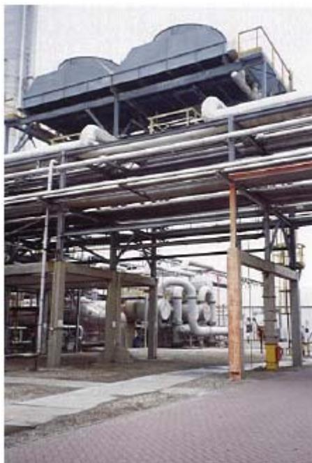
Figure 2.13 : Exemple d'un refroidisseur de liquide par air sec dans un procédé chimique
