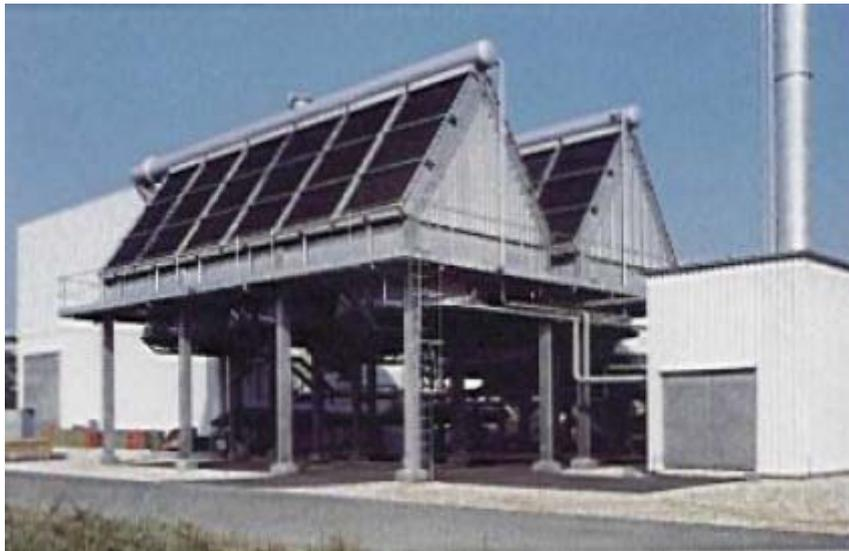
**Figure 2.15 : Exemple d'un condenseur à air pour la condensation des fumées d'échappement d'une turbine [tm111, BDAG, 1996]**
