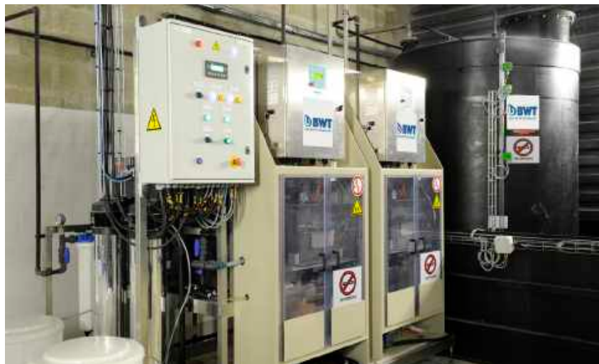
Pour le traitement des TAR, BWT propose la solution d'électrolyse de sel BWT ECO-MX. Ici, une application sur le site de la chaufferie de l'entreprise Idex à La Défense.
